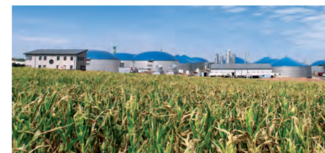
Bio-refinery plant in Könnern, total output: 17,5 MW therm
